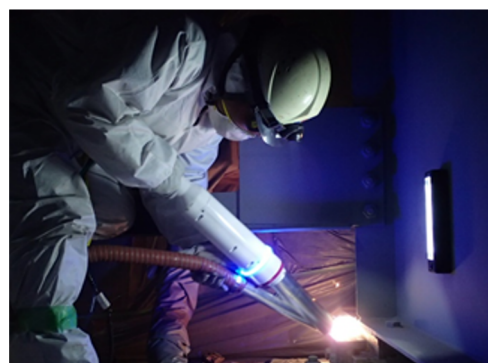
玉鉾橋施工の様子
