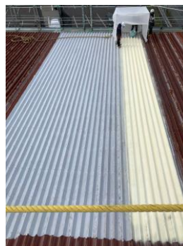
SOSEラインロボを用いた施工の様子
